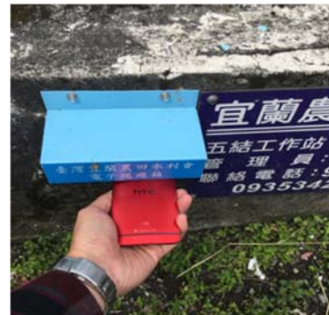
NFC 卡安裝於水門
